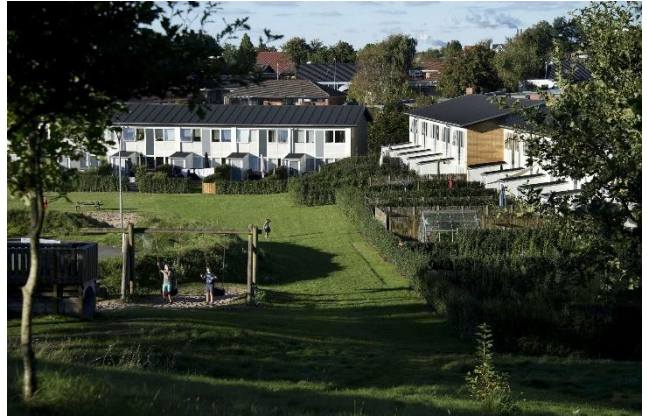
Nye facader og indgangspartier samt nye vinduer
