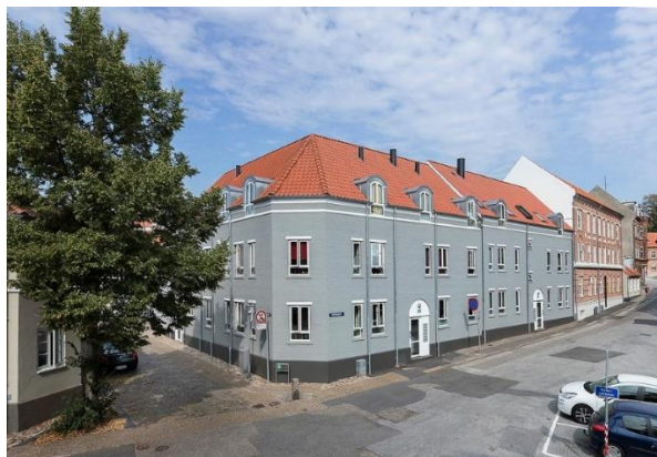
Nypudset facade samt nye teglsten på taget
