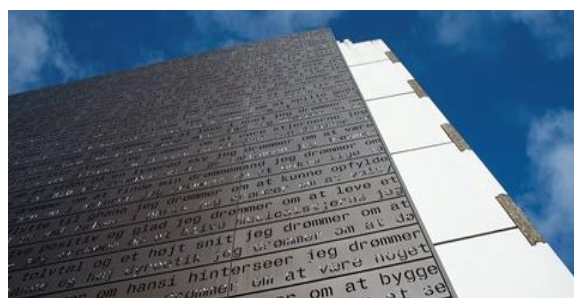
Nye isolerede gavle – med citater om drømme. Foto fra afdelingens hjemmeside.
