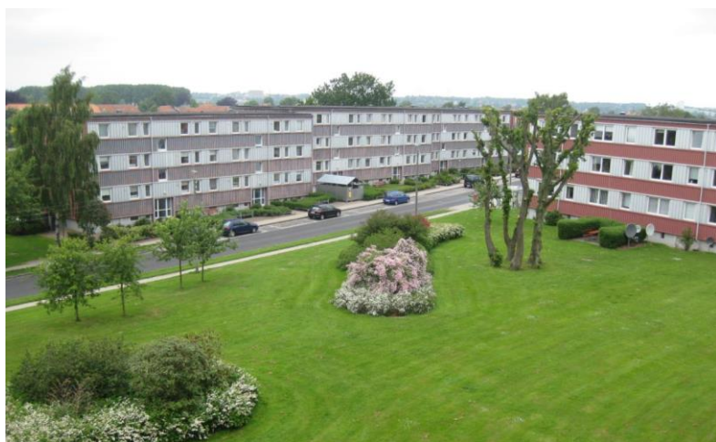
Bebyggelsen med fri-/udearealer før renovering
