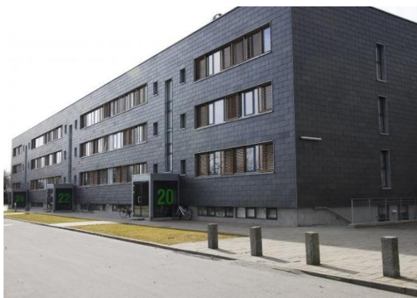
Boliger som har fået ny klimaskærm – facade med nye indgangspartier
