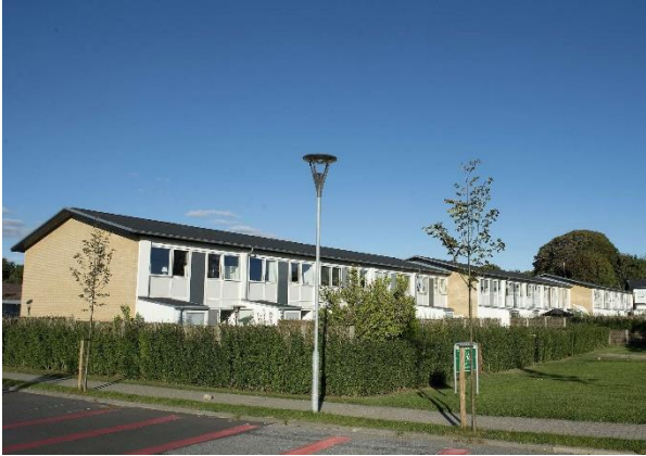
Boliger, som har fået nyt tag og udbedret facader
