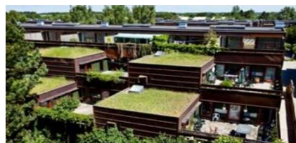
Nye tage på lavhusene efter renovering og isolering
