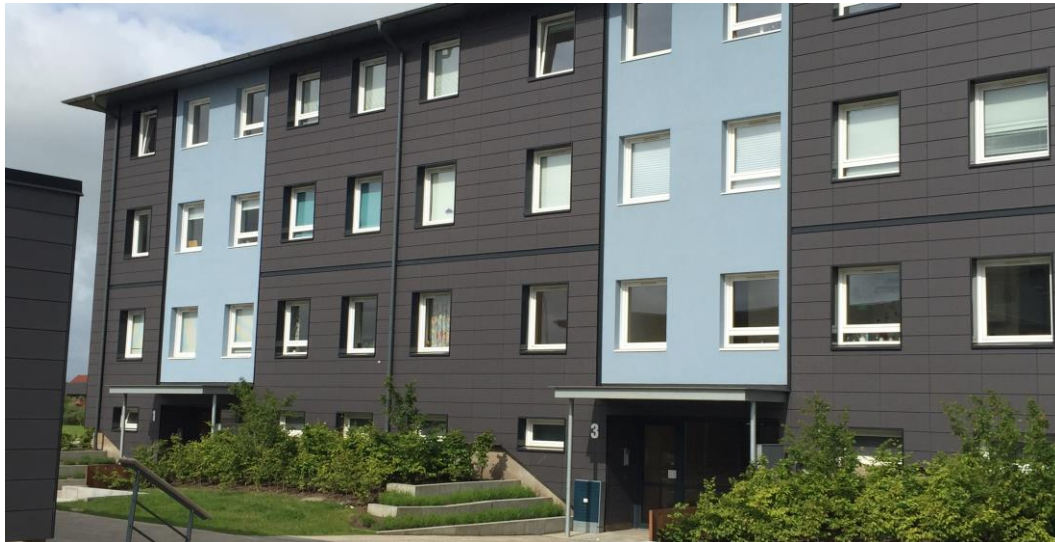
Ejendommene under Boligforeningen PM's afdeling 11 er helt nyrenoverede.
