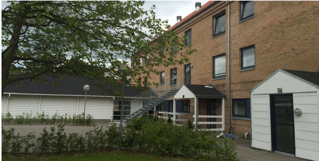
Bygningen, som huser alle 21 startboliger under StartBo i Randers.
