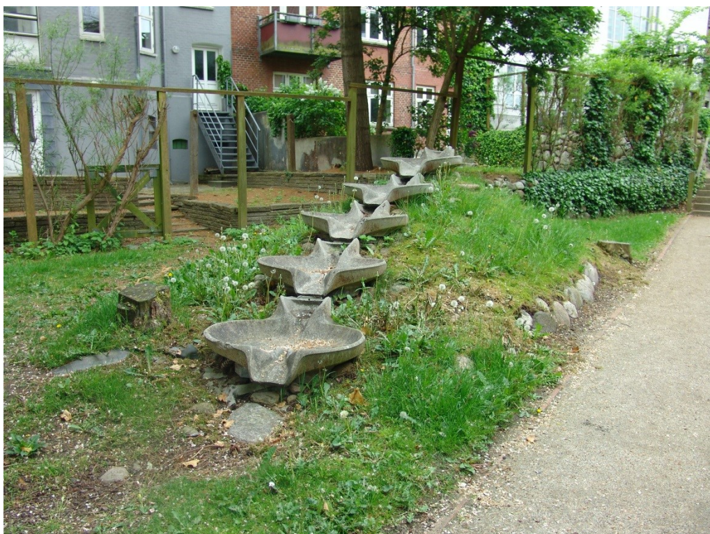
Fredensgade-karréen sover Tornerosesøvn. Selv regnvandsanlægget er gået i stå til trods for, at lokal afledning af regnvand er meget aktuelt. Karen Attwell, 2016.
