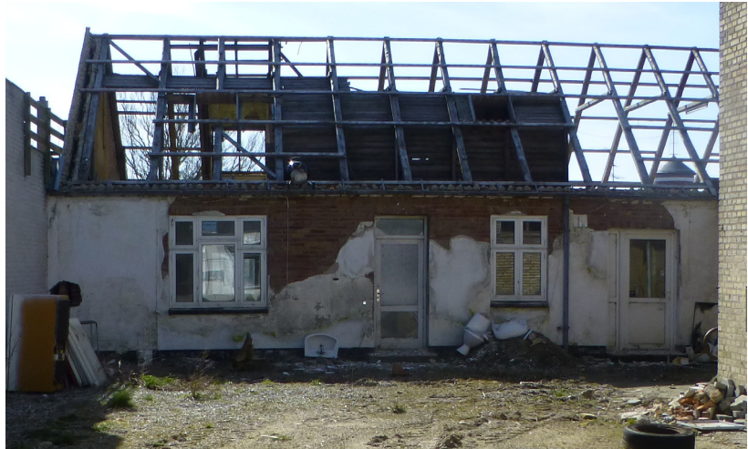
Nedrivning af kondemneret ejendom med op til 100% støtte
