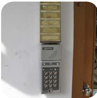
Kodetastatur for åbning af opgangsdøren
