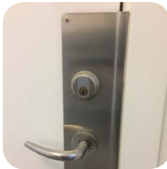
Stålplade der gør det svært for tyven at bryde døren op
