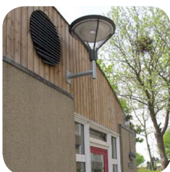
Højt monteret lampe med symmetrisk belysning
