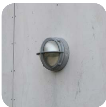
Skotlampe med reflektor for at undgå blænding
