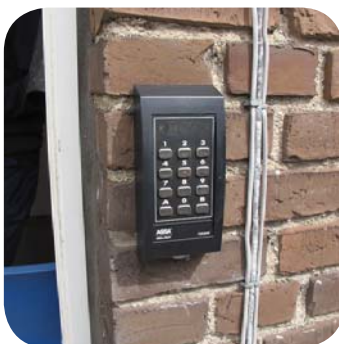
Onlinelæser med kodetastatur monteret udendørs
