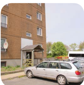
Beplantning ryddet, TV-overvågning og runderingsvagt
