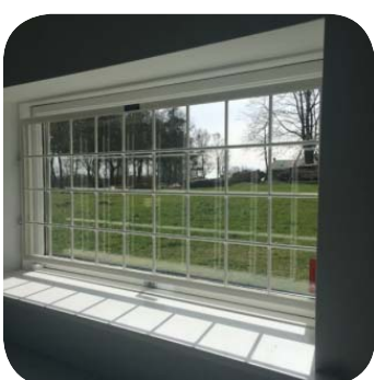
Gitter monteret på kældervindue.
