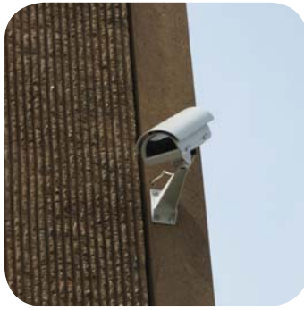
Videokamera monteret på arm
