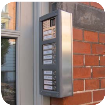
Dørtelefon med lys og videokamera
