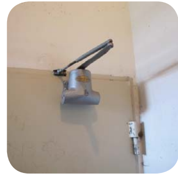
Dørpumpe der sørger for at døren lukkes automatisk
