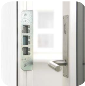
Sikkerhedsslutblik med ekstra skruer på ny dør
