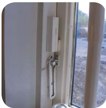
Magnetkontakter giver alarm ved åbning
