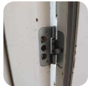
Udvendigt hængsel med nøkke
