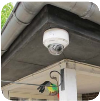
Lavt placerede kameraer skal være vandalsikrede
